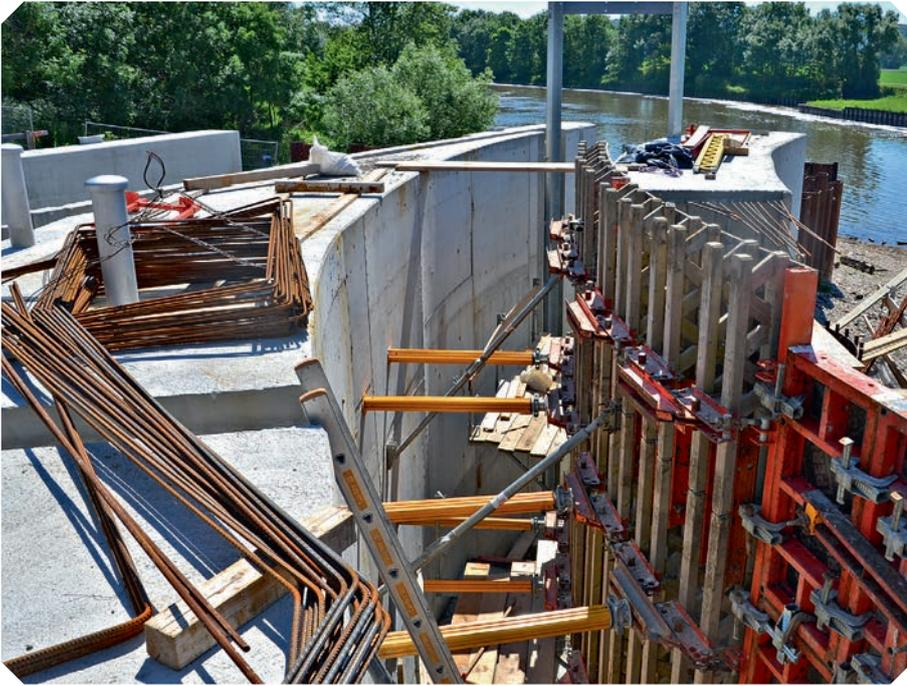
Bild 5: Beide Pilotanlagen sind mit lichtoffenen, schachtartigen Bypässen ausgestattet. Das Foto zeigt den Bypass an der Wasserkraftanlage Öblitz im Bau (Blick zum Unterwasser, Foto: Ebel)
