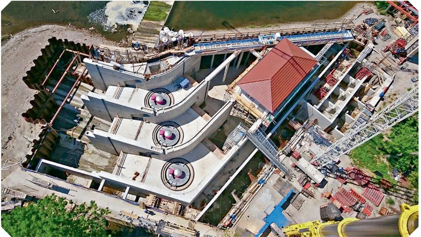
Bild 3: Wasserkraftanlage Öblitz mit Leitreechen-Bypass-System im Bau (Foto: Kehl)
